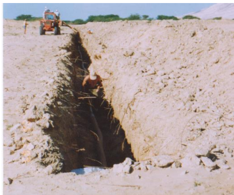
3. ábra. Perforált dréncső fektetése a dréncsatornába (Cserni, 1990)
